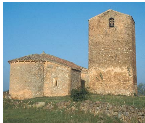
El torreón de Aldealpozo tiene sus esquinas redondeadas , opción constructiva que confiere más consistencia. Se unió a la iglesia en 1884 y se utiliza como campanario.
